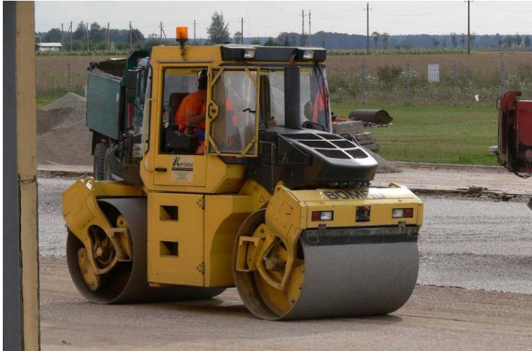
45 pav. Grunto sutankinimas vibro volu
