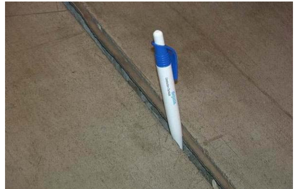
72 pav. Deformacinė siūlė autokrautuvių važiavimo zonoje.
