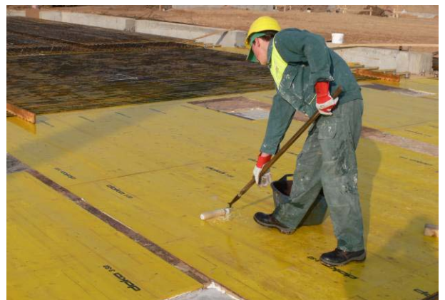
60 pav. Perdangos pakloto padengimas klojinių tepalu užpurškianti arba voliuku.
