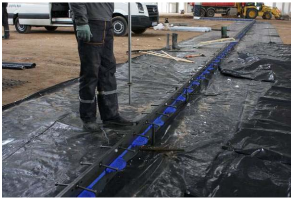
77 pav. Technologinių siūlių įrengimas.
