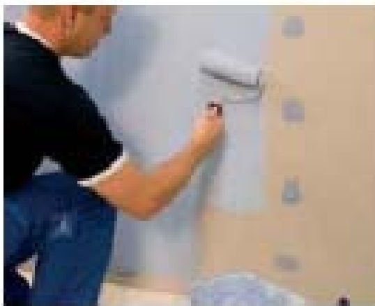
15 pav. Hidroizoliacijos užnešimas.
