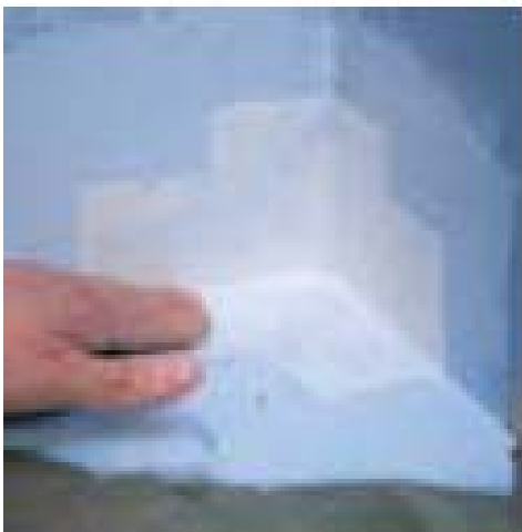
20 pav. Sutvirtinimo juostos montavimas.
