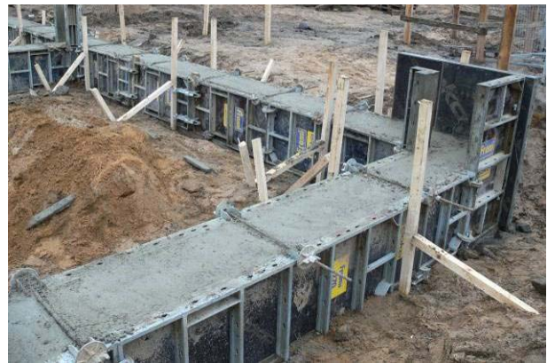
27 pav. Klojinių išramstymas objektuose
