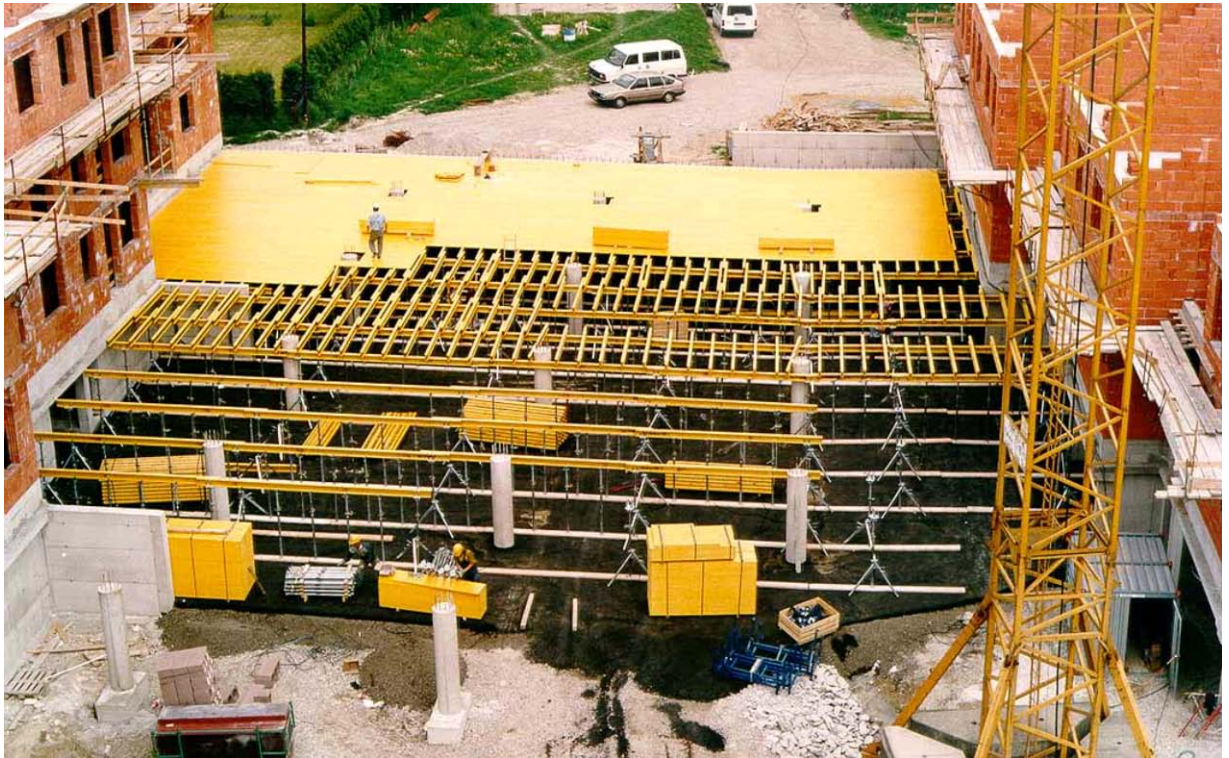
81 pav. Perdangos klojinių montavimo eiliškumas.
