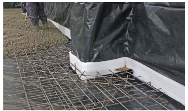
47 pav. Sienų, kolonų atskyrimas nuo grindų betono deformatyve medžiaga.
