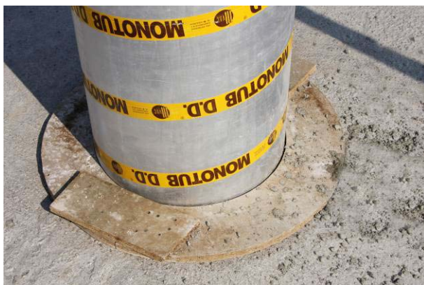
45 pav. Popierinės kolonos apačios ir viršaus užfiksavimas projektinėje padėtyje
