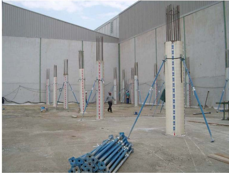
46 pav. Plastmasinių kolonų montavimas objekte
