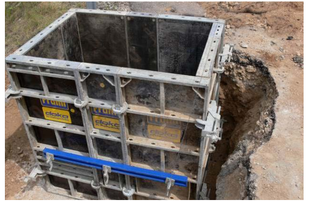
29 pav. Pamatų po kolonomis iš klojinių Frami montavimas
