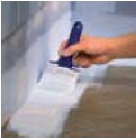
19 pav. Hidroizoliacijos užnešimas.
