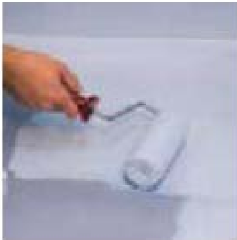
26 pav. Hidroizoliacijos užnešimas.
