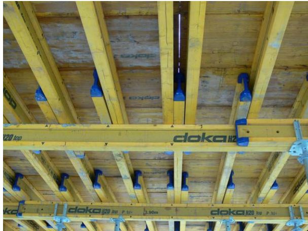
67 pav. Klojinio plokštės sandūra.
