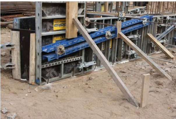
27 pav. Klojinių išramstymas objektuose
