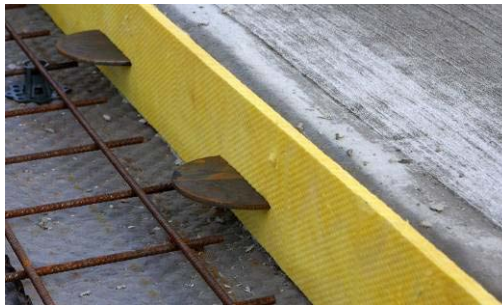
6 pav. Temperatūrinė siūlė
