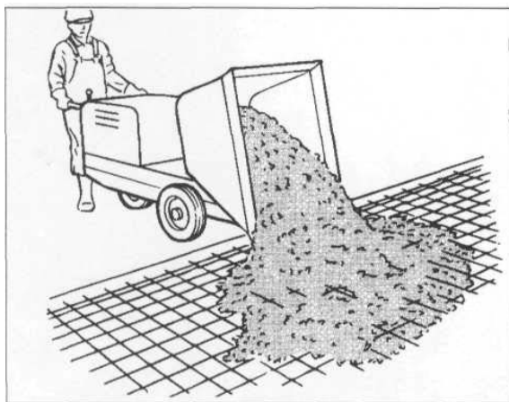
52 pav. Betono atvežimas.
