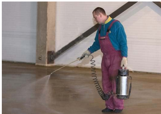
81 pav. Betono paviršiaus apsauginės plėvelės užnešimas.
