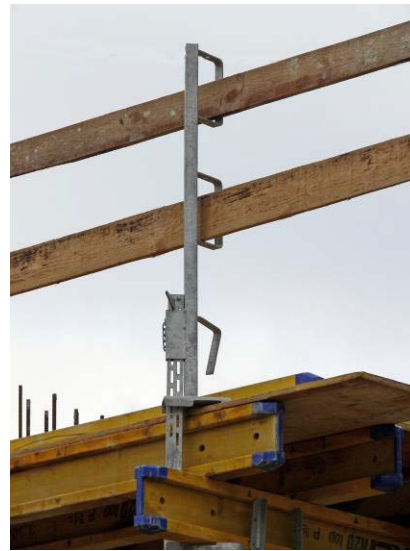
59 pav. Apsauginių turėklų montavimas.
