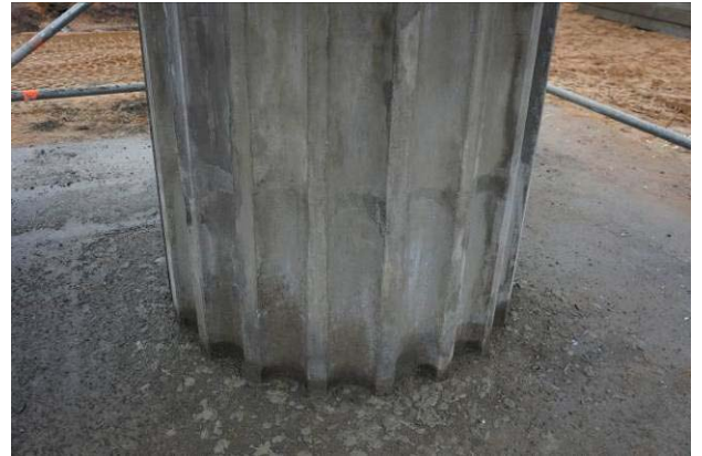
49 pav. Kolonos klojiniai: a) mediniai klojiniai sistemos TOP 50, b) klojiniai nuimti.
