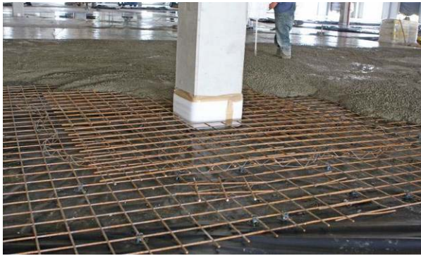
47 pav. Sienų, kolonų atskyrimas nuo grindų betono deformatyve medžiaga.
