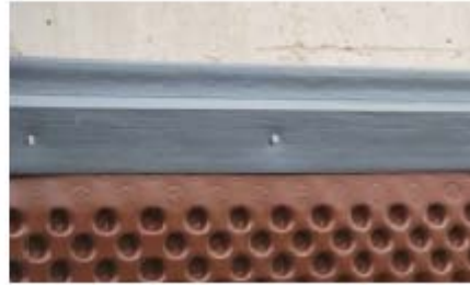
6 pav. Sienų ir grindų sandūra.
