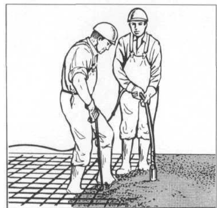
53 pav. Betono sutankinimas.
