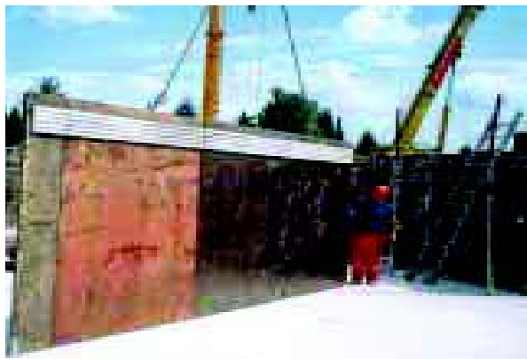
69 pav. Fibro betono plokštės tvirtinimas prie klojinio
