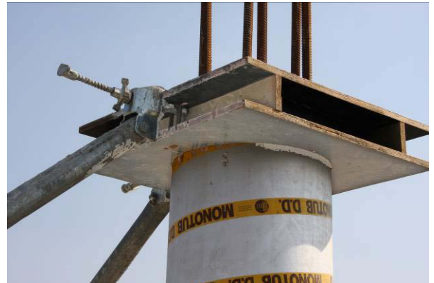
45 pav. Popierinės kolonos apačios ir viršaus užfiksavimas projektinėje padėtyje
