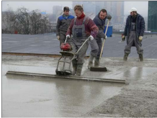
55 pav. Betono sutankinimas paviršiniu vibruotuvu.
