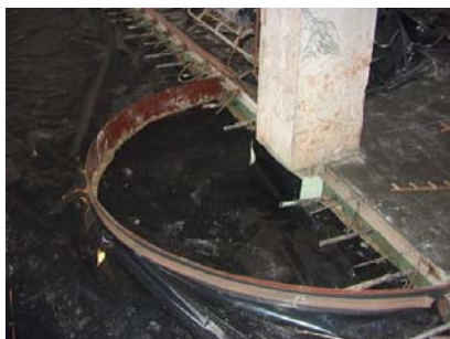
17 pav. Apvalaus kolonos pamato atskyrimas.
