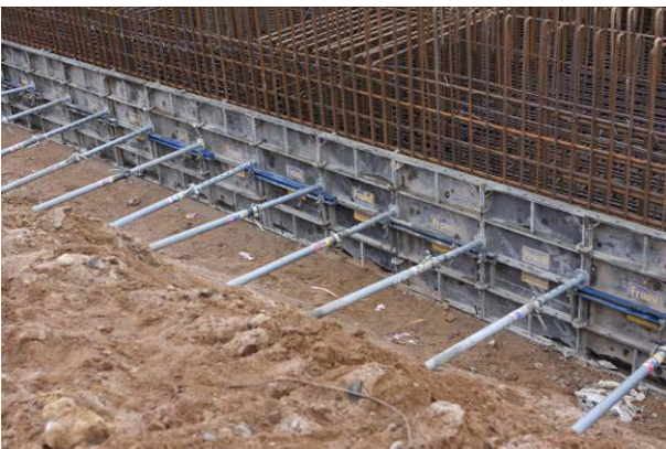
28 pav. Klojinių išramstymas objektuose
