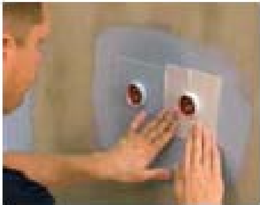
14 pav. Fibergum tvirtinimas.
