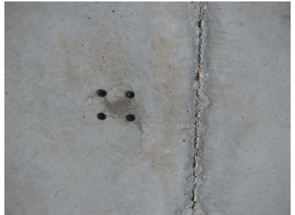
9 pav. Fiksatoriai betone
