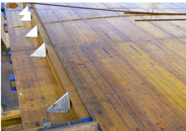
65 pav. Metalinių trikampių atramos išilgai faneros lakšto.
