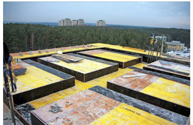
86 pav. Sijų formavimas iš dėžių sumontuotų ant lygaus pakloto.
