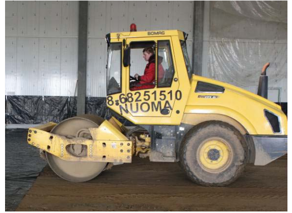
41 pav. Pagrindo sutankinimas volu.
