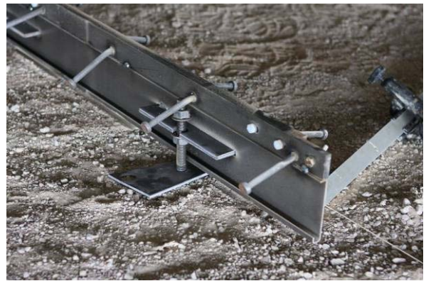
77 pav. Technologinių siūlių įrengimas.
