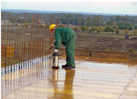
60 pav. Perdangos pakloto padengimas klojinių tepalu užpurškianti arba voliuku.
