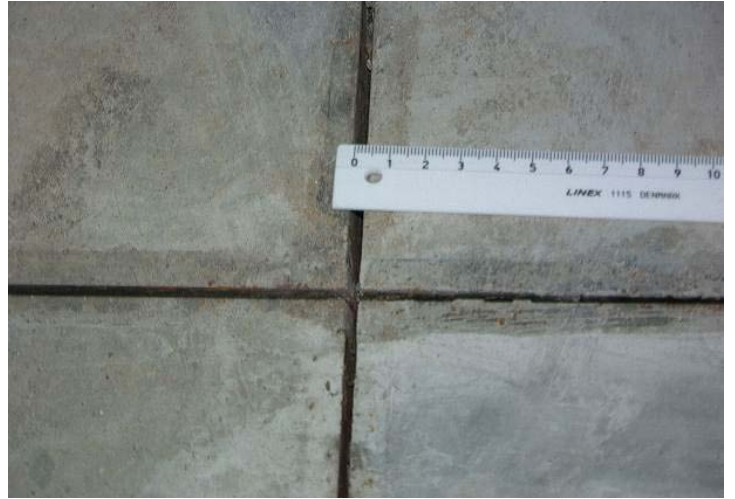
76 pav. Deformacinė siūlė po dviejų metų (betonui traukiantis siūlės prasplėtė 6–10 mm).
