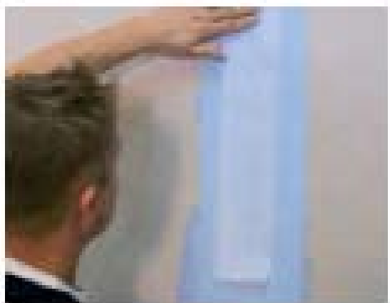
13 pav. Sutvirtinimo juostos klijavimas.
