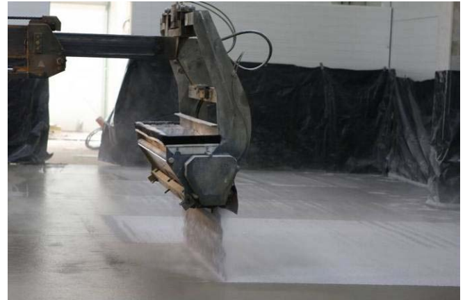
68. pav. Sauso betono paviršiaus kietiklio barstymo įrenginys.
