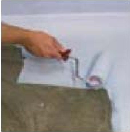
25 pav. Hidroizoliacijos užnešimas
