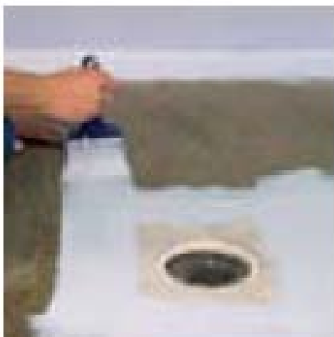
24 pav. Hidroizoliacijos užnešimas
