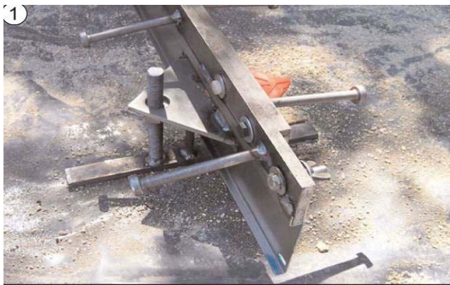
11 pav. Viena iš temperatūrinių siūlių konstrukcijų.
