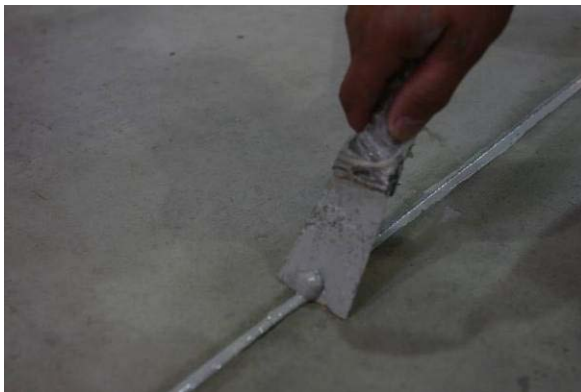
82 pav. Siūlių užtaisyimas paprastu silikonu.
