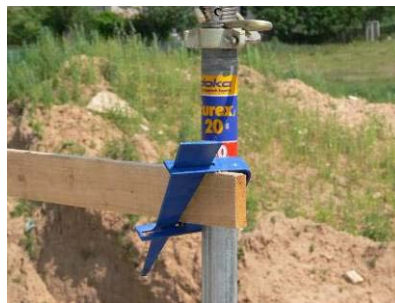
75 pav. Lentos fiksavimas su pleištinė apkaba B.
