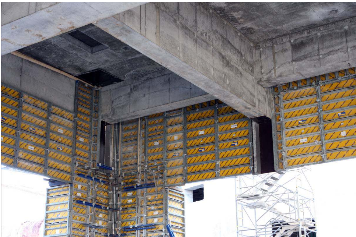
88 pav. Užbetonuotos masyvios rygelinės perdangos dalinai išmontuoti klojiniai.
