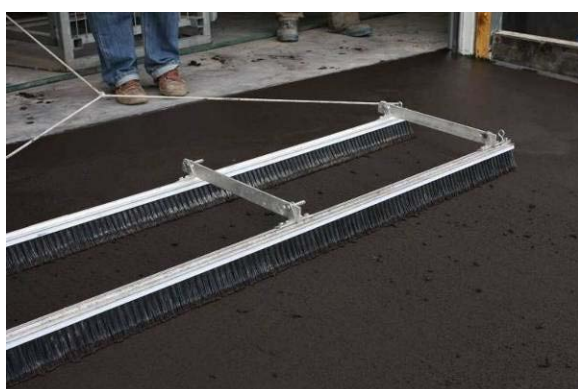
28 pav. Šluotuota betono paviršiaus struktūra
