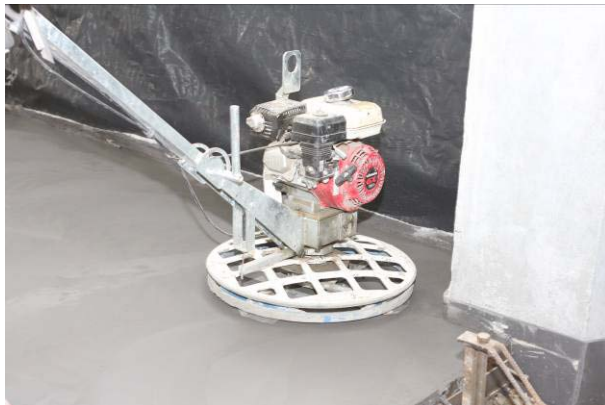
49 pav. Betono glaistymas objekte.
