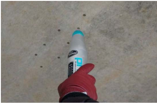
95 pav. Perdangos betono stiprio matavimas su Šmito plaktuku.
