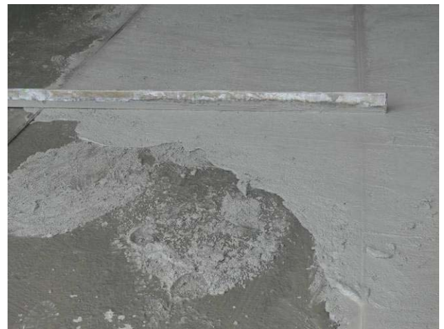
70 pav. Užnešimas „šlapias ant šlapio“.
