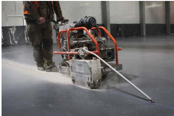
74 pav. Šviežio betono pjovimo mašina Soff-cut.
