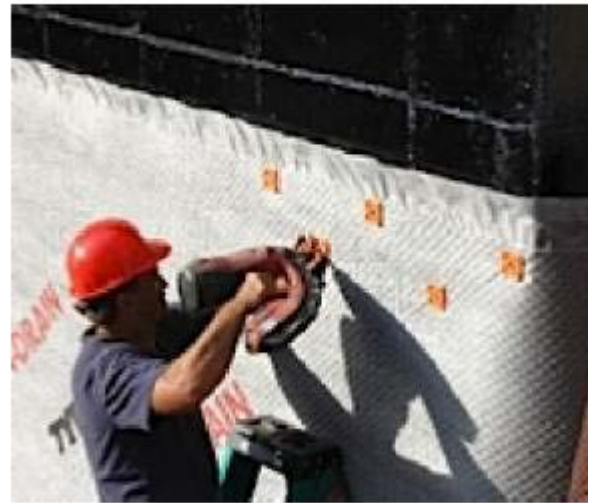
Laikiklų DELTA FAST NER montavimas
