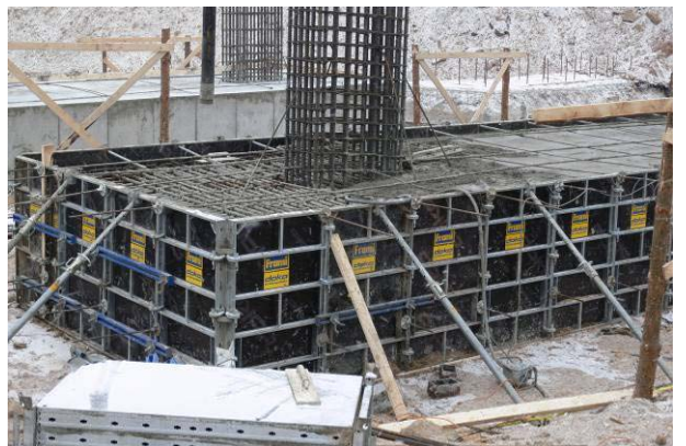
28 pav. Klojinių išramstymas objektuose
