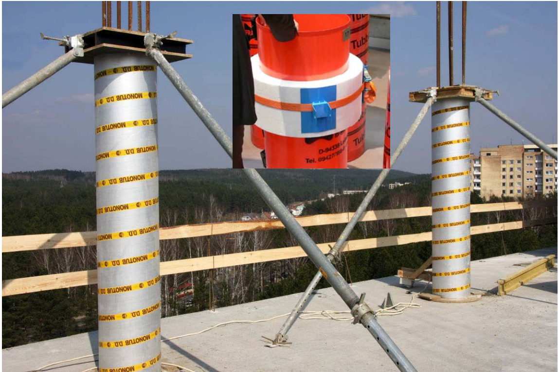
44 pav. Popierinės kolonos viršaus fiksavimas projektinėje padėtyje paramščiais
