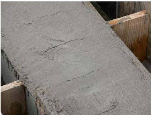
8. pav. Betono įtrukimas virš armatūros
