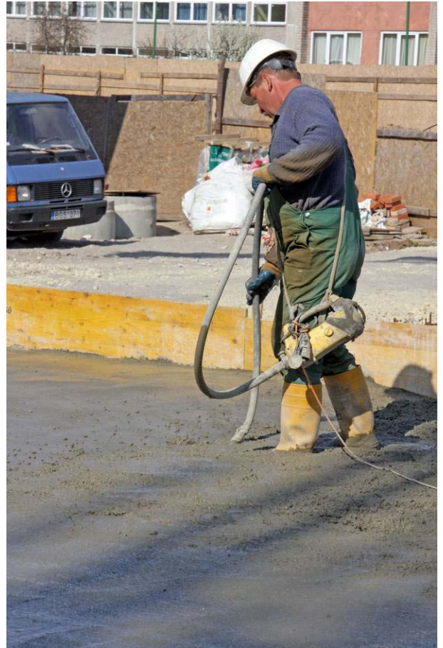
5 pav. Betono pylimas, paskleidimas, reikiamo betono storio užtikrinimas.
