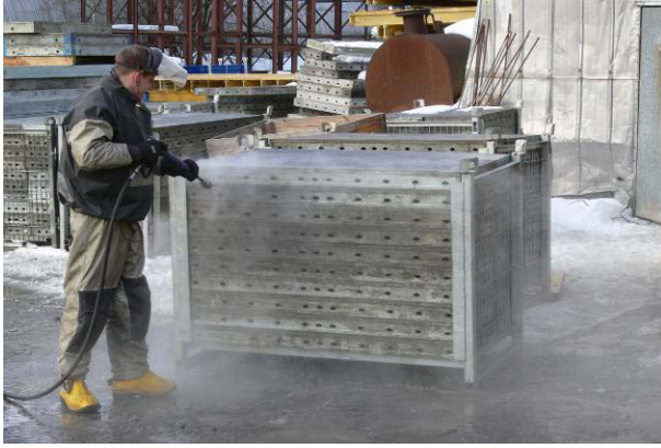
25 pav. Klojinių valymas ir sandėliavimas
