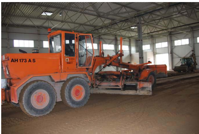
39 pav. Nurodyto storio skaldos ir žvyro sluoksnio paskleidimas.
