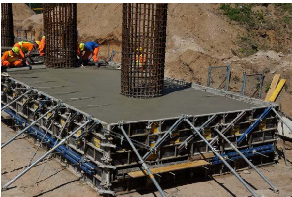
31 pav. Masyvių pamatų iš klojinių Frami montavimas
