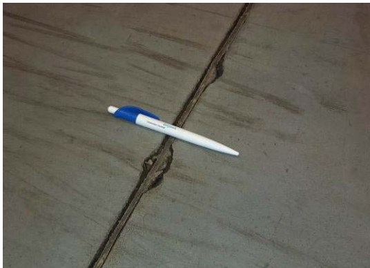
72 pav. Deformacinė siūlė autokrautuvių važiavimo zonoje.
