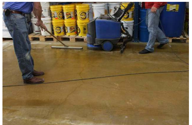
88 pav. Papildomas paviršiaus apdorojimas pagerinant betono eksploatacines savybes.
