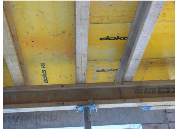
68 pav. Plokštė klojama išilgai sijų.
