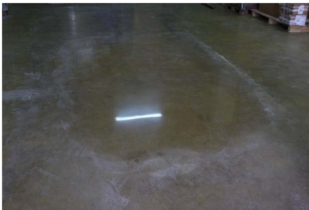
88 pav. Papildomas paviršiaus apdorojimas pagerinant betono eksploatacines savybes.
