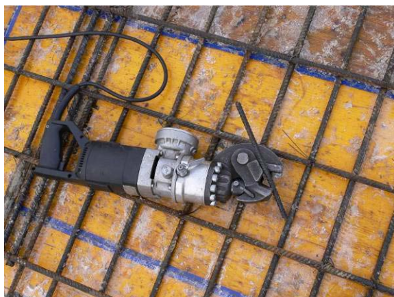
107 pav. Armatūros rišimas ir fiksavimas
