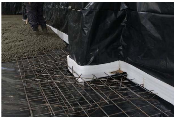
78 pav. Izoliacinė siūlė pagal sienas.
