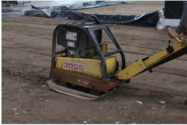
40 pav. Pagrindo sutankinimas grunto tankintuvu
