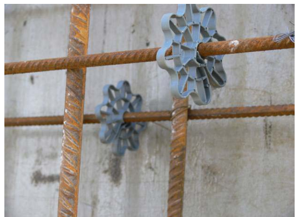
107 pav. Armatūros rišimas ir fiksavimas
