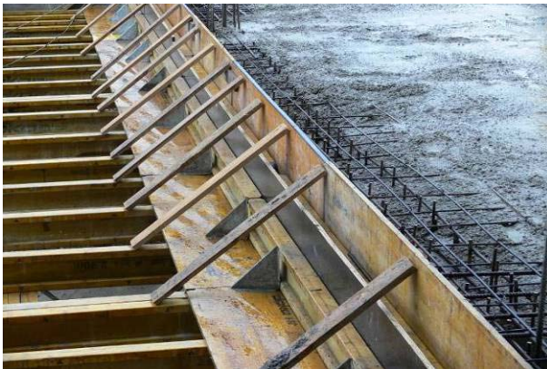
63 pav. Metalinių trikampių atramos ir mediniai spyriai.
