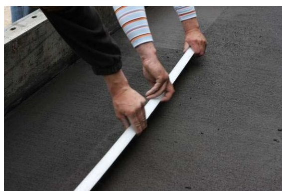
28 pav. Šluotuota betono paviršiaus struktūra
