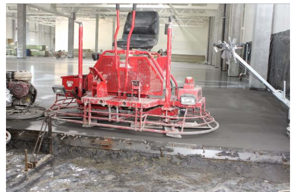
49 pav. Betono glaistymas objekte.
