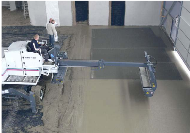
68. pav. Sauso betono paviršiaus kietiklio barstymo įrenginys.
