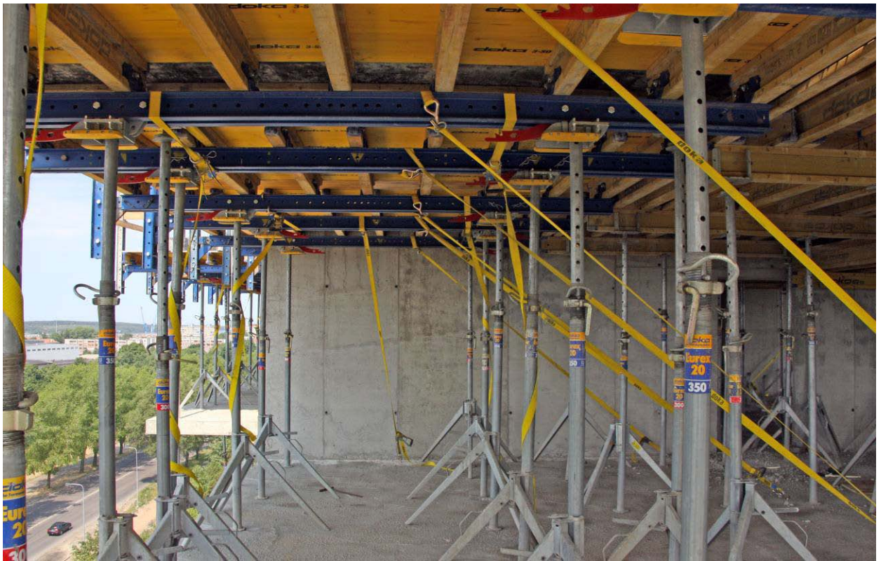
80 pav. Perdangos krašto stalų fiksavimas prie perdangos diržais.
