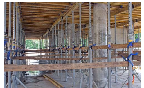
76 pav. Statramsčių sutvirtinimas.
