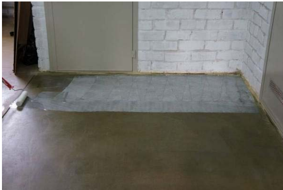
87 pav. Papildomas paviršiaus apdorojimas pagerinant betono eksploatacines savybes.
