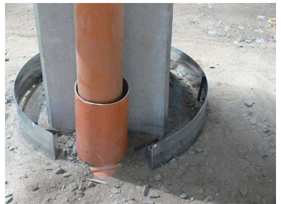
79 pav. Kolonos atskyrimas.
