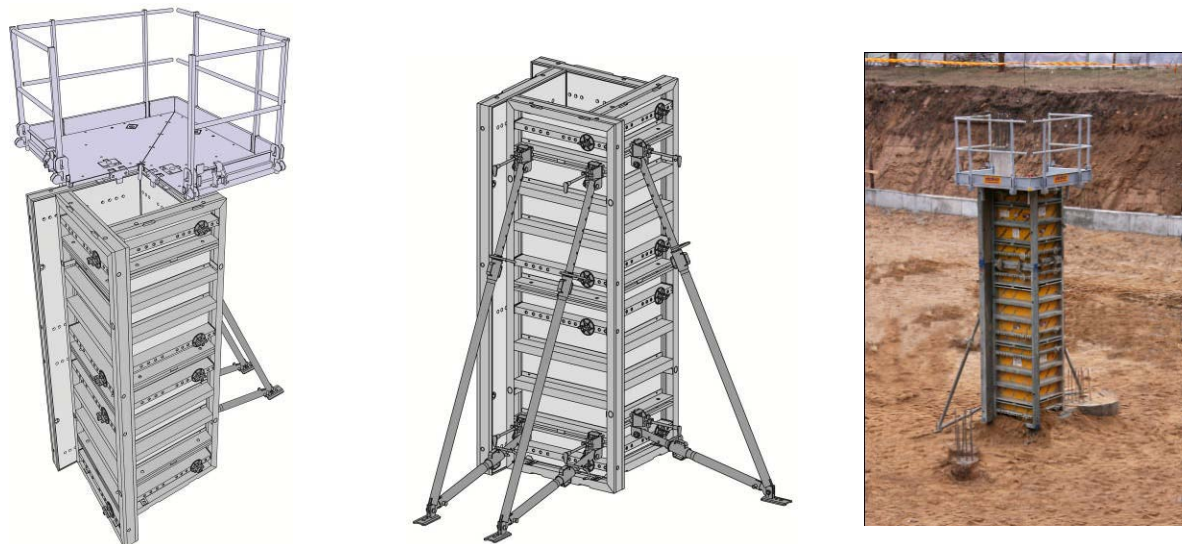
39 pav. Kolonos iš universaliųjų skydų montavimas
