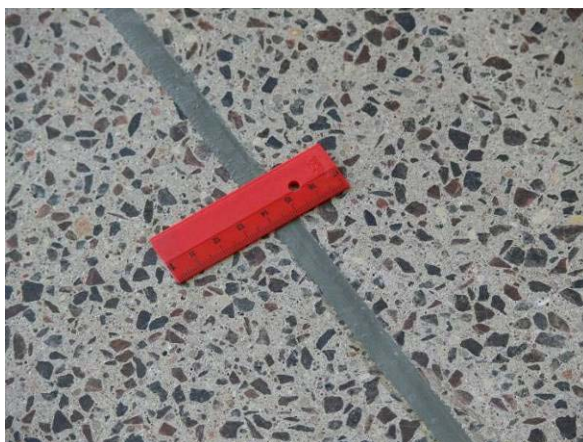
83 pav. Siūlių užtaisyimas poliurėja.
