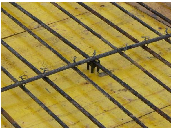
108 pav. Armatūros rišimas ir fiksavimas
