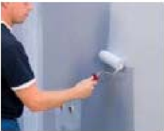
16 pav. Hidroizoliacijos užnešimas.
