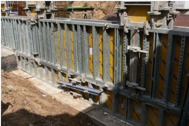
30 pav. Pamatų iš klojinių Framax Xlife montavimas
