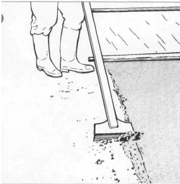
63 pav. Švariai nuvalomas gretimo betono paviršiaus kraštas,
