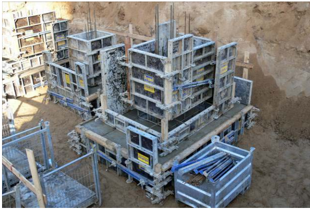
29 pav. Pamatų po kolonomis iš klojinių Frami montavimas
