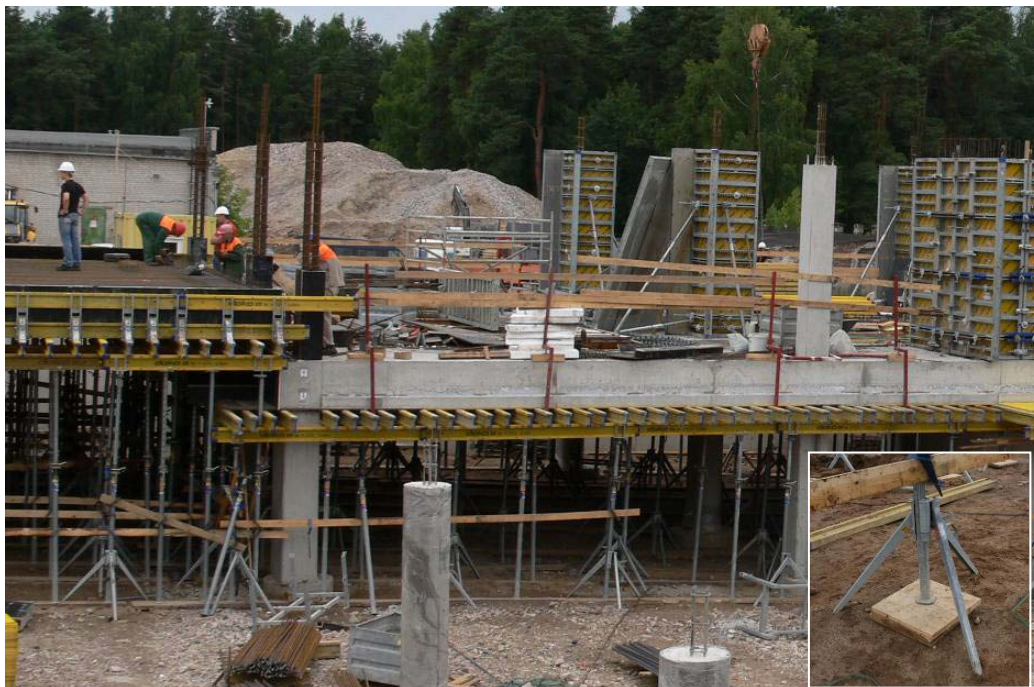
50 pav. Pagrindo paruošimas ir klojinių montavimas
