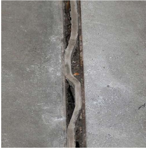
76 pav. Deformacinė siūlė po dviejų metų (betonui traukiantis siūlės prasplėtė 6–10 mm).
